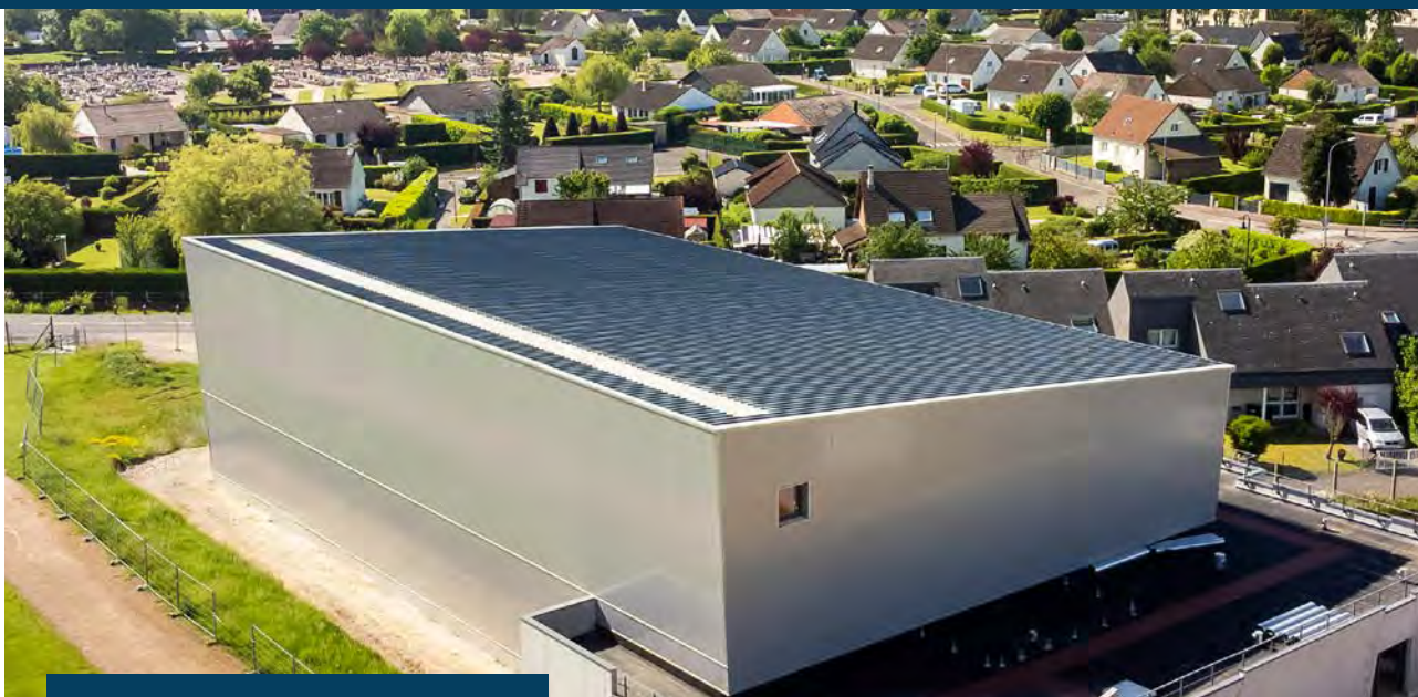
Sporthal bedekt door ons JI Roof 1000 paneel.
