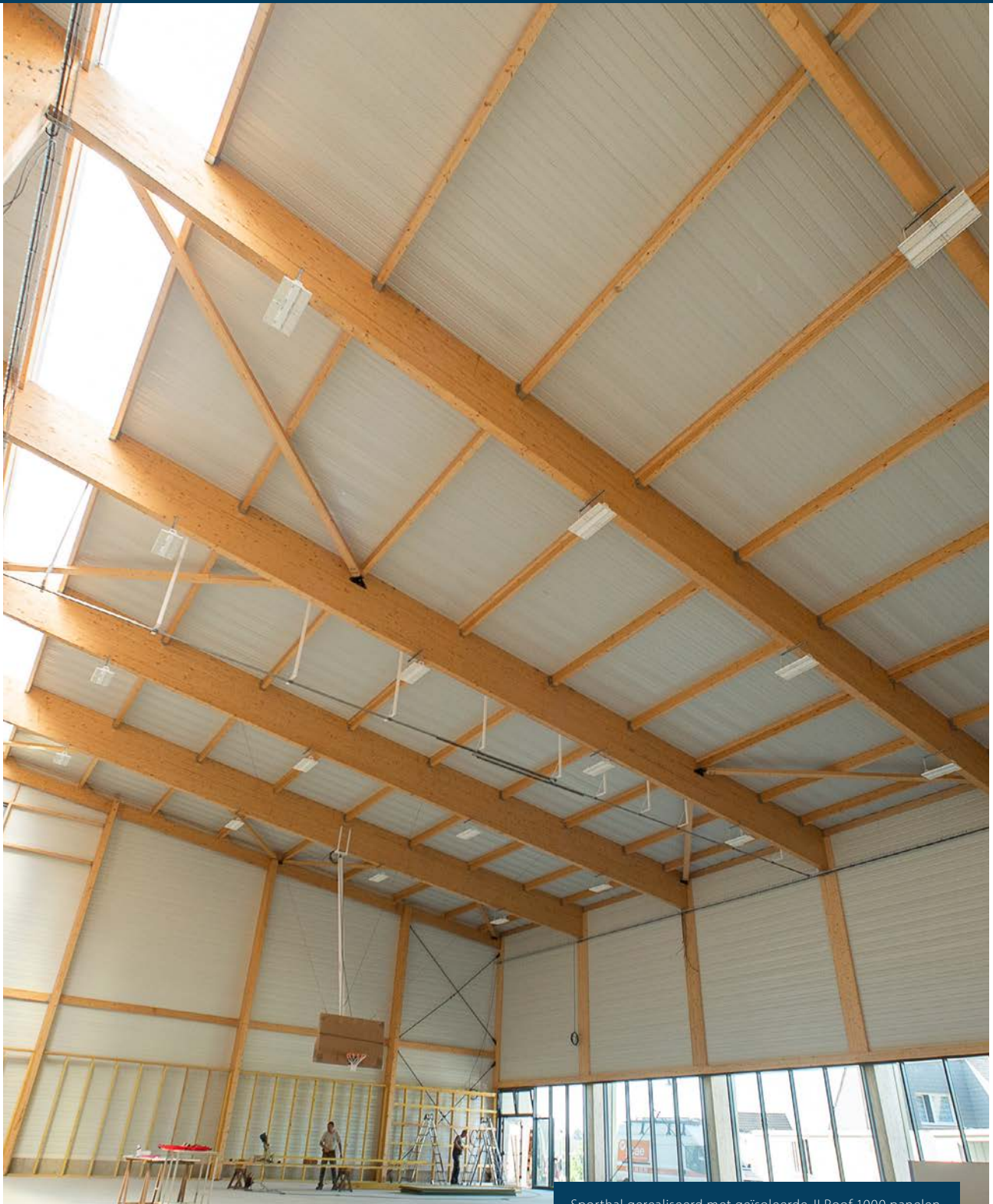
Sporthal gerealiseerd met geïsoleerde JI Roof 1000 panelen.
