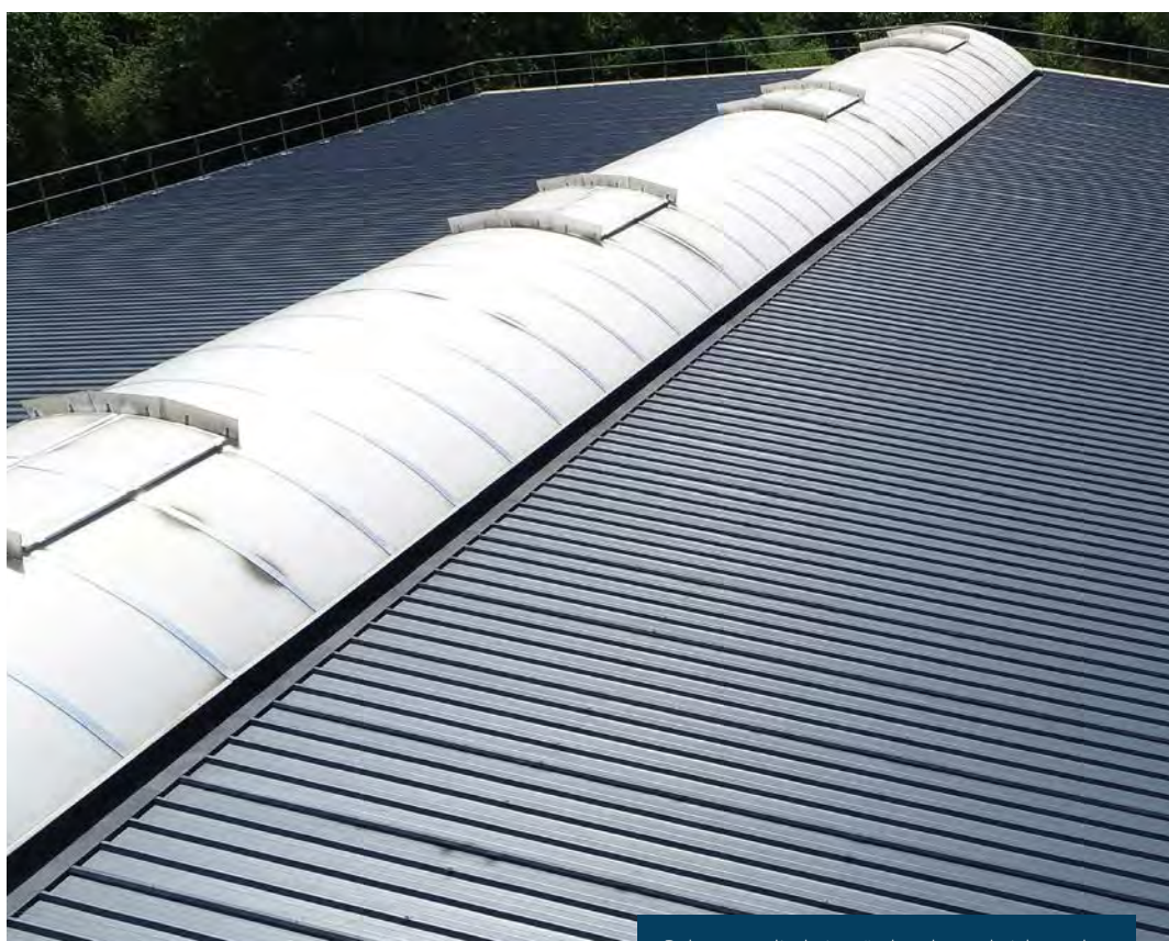
Dak vervaardigd uit geïsoleerde sandwichpanelen
